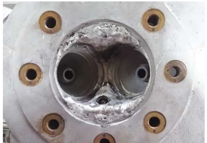
Kopf nach den Schweißarbeiten, Foto: Klaus. Jung
